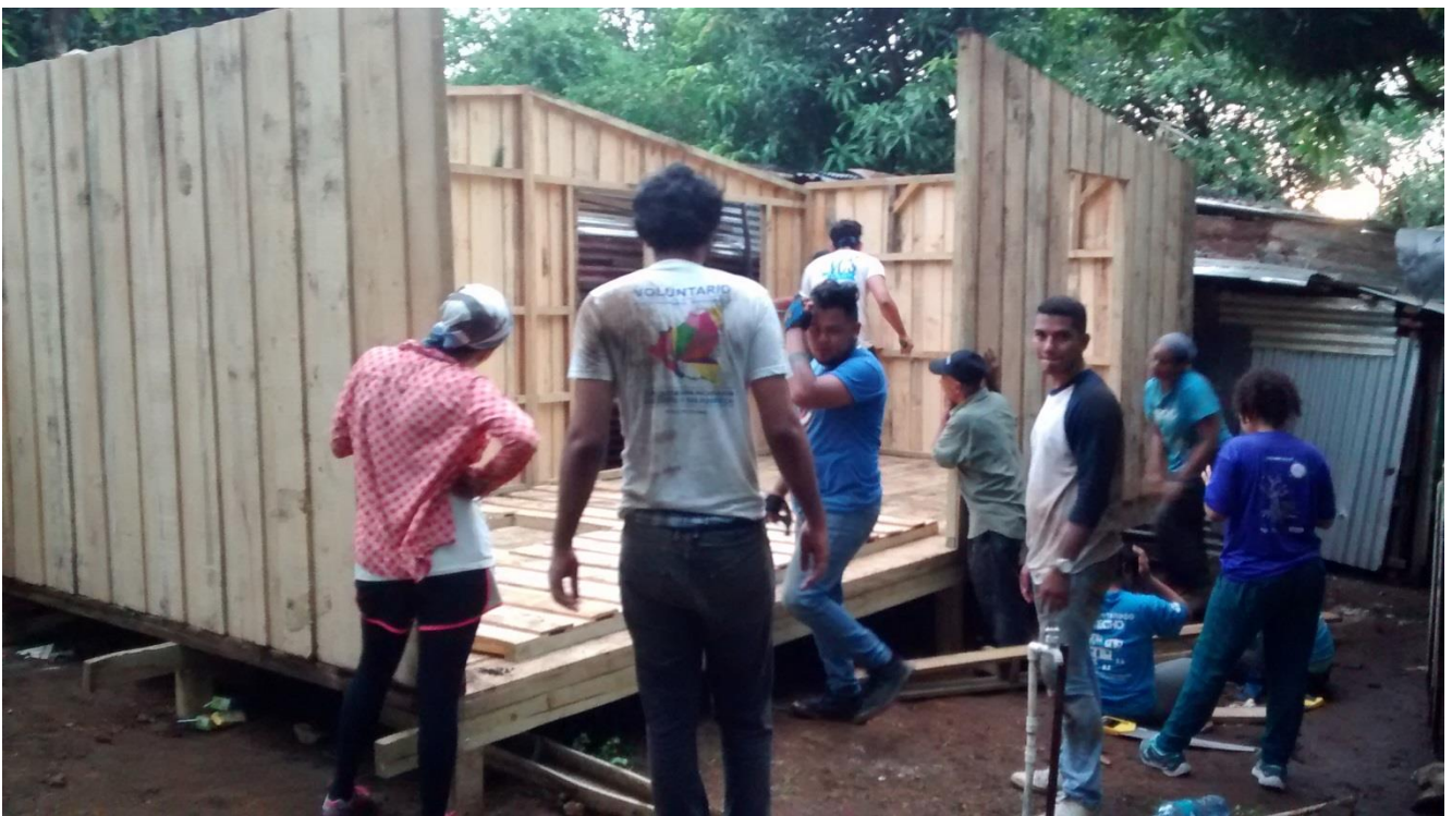
Hausbau mit "Techo"
