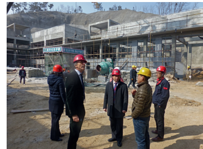
5. Ministerialdirektor Dr. Karl Eugen Huthmacher (BMBF) auf der VEZ-Baustelle in Qingdao, März 2014
