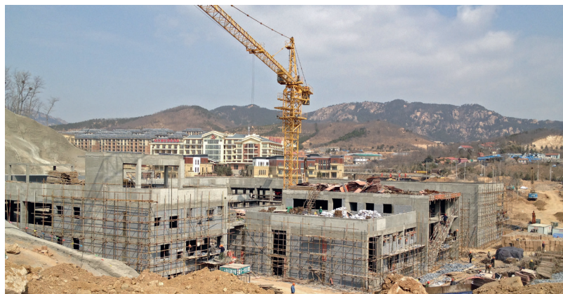
7. Baustelle VEZ, Qingdao im März 2014
