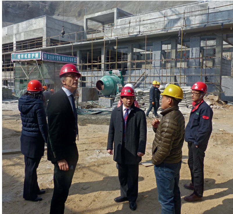
6. Ministerialdirektor Dr. Huthmacher bei Begehung der VEZ-Baustelle, März 2014
