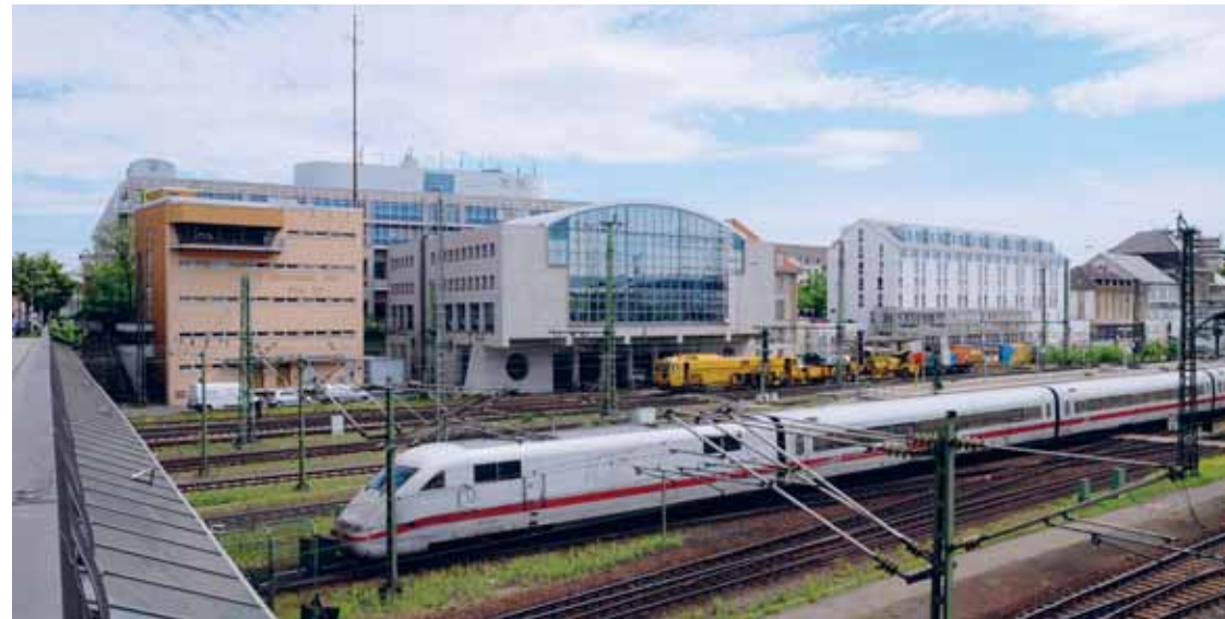
Schiienenverkehr ohne Störung: TU-Informatiker arbeiten an Sicherheitslösungen.
