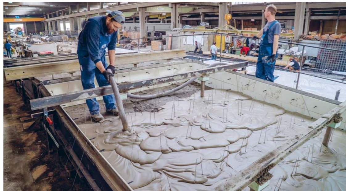
Aus einem Guss: Flüssiger mineralischer Dämmstoff kommt in Form.
