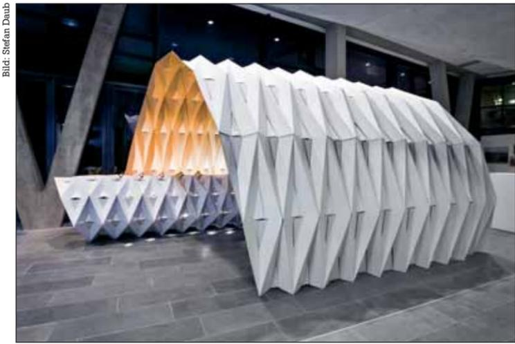
wurde der Entwurf eines Falterwerks aus Wellpappe ausgewählt. Das Material Wellpappe war aufgrund seiner Stabilität und Faltbarkeit optimal für diesen Entwurf geeignet. Mit ihm lassen sich Bauteile von 1,60 Meter mal 1,90 Meter herstellen, durch deren Verbindung eine maximale Gesamthöhe von 2,70 Metern und Bogenspannweite von 3,50 Metern erreicht werden.
