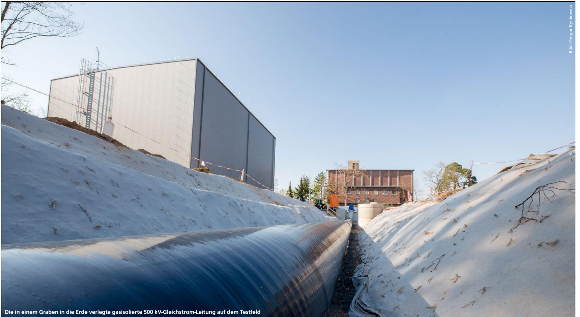
Die in einem Graben in die Erde verlegte gasisolierte 500 kV-Gleichstrom-Leitung auf dem Testfeld
