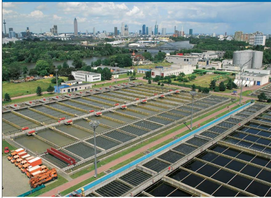
Wir betreiben die zwei größten Abwasserreinigungsanlagen in Hessen mit einer Schlammmentwässerungs- und -verbrennungsanlage sowie ein Kanalnetz mit rund 1.600km Länge.
