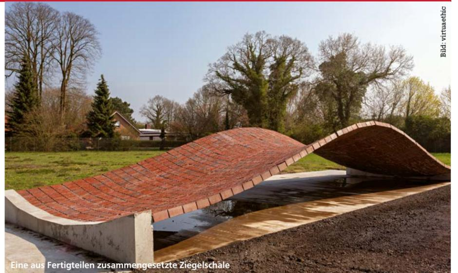
Eine aus Fertigteilen zusammengesetzte Ziegelschale
