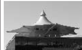
Tribünenüberdachungen Formel 1, Istanbul
