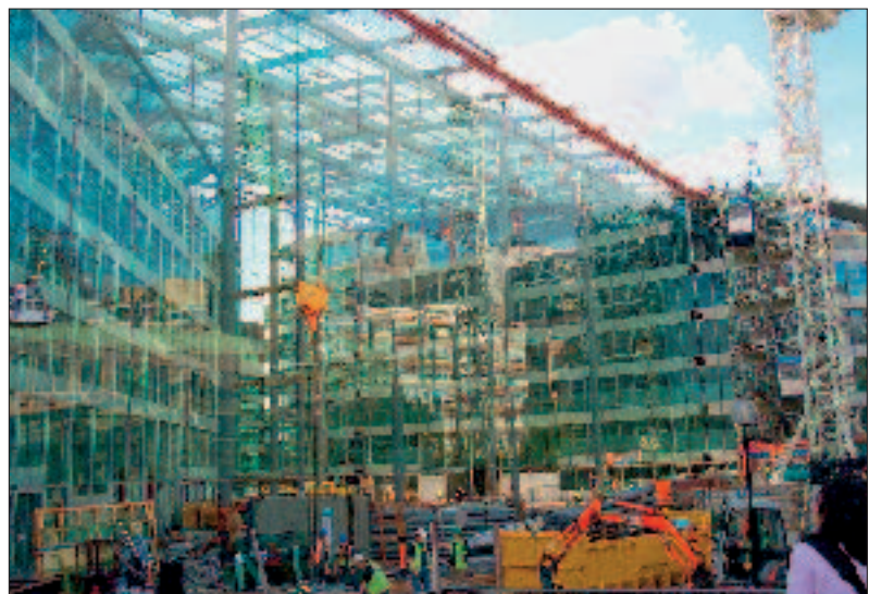
Bild 4: Tower Place London
