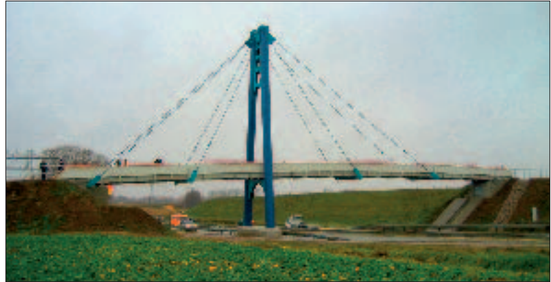
Bild 2: GFK-Brücke Schwerin GRP-Bridge Schwerin, Germany
