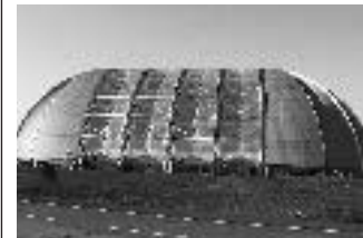
„Tropical Islands“- ETFE-Folienkissenkonstruktion
