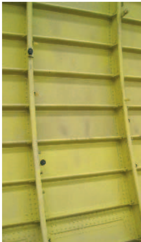
Bild 1 Unbeschädigtes Segment eines Flugzeugrumpfs (TU Darmstadt SzM, Fraunhofer LBF)
