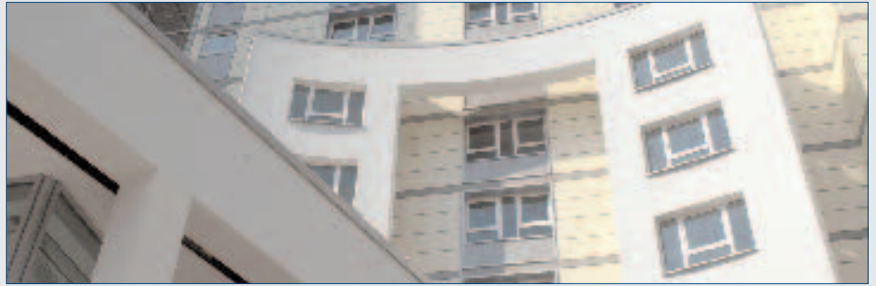
Wohnen im Alleeviertel in Frankfurt Höchst Niedrigenergiebauweise mit Solarfassade
