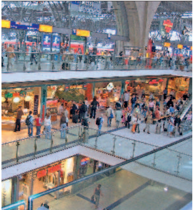
Abb. 1 Mehrstöckiger Hauptbahnhof Berlin mit Einkaufsbereich Central station in Berlin with several floors and shopping mall
