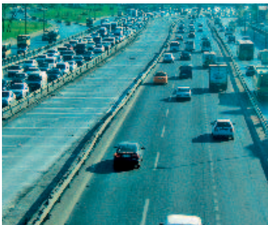
Abb. 3 Vorbereitete Spur für neue Schnellbuslinie in Istanbul (03/2007) Prepared lane for a new rapid bus line to Istanbul airport (03/2007)
