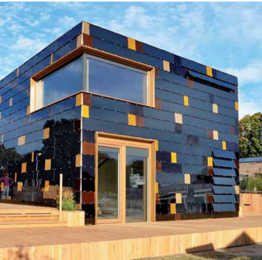
Abbildung 4 Ansicht des surPLUS-home mit geöffneter Zuluft zur Klimadecke.
