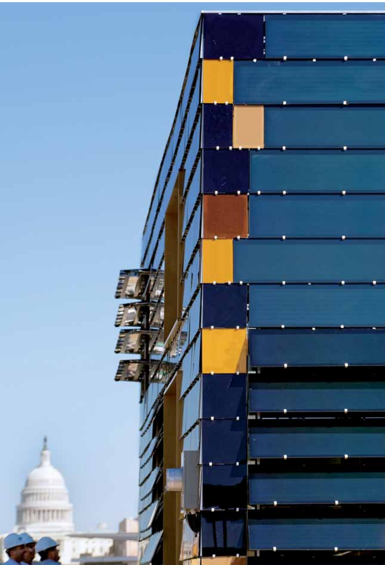
Abbildung 1 Fassade des surPLUShome mit solaraktiven Lamellen.
