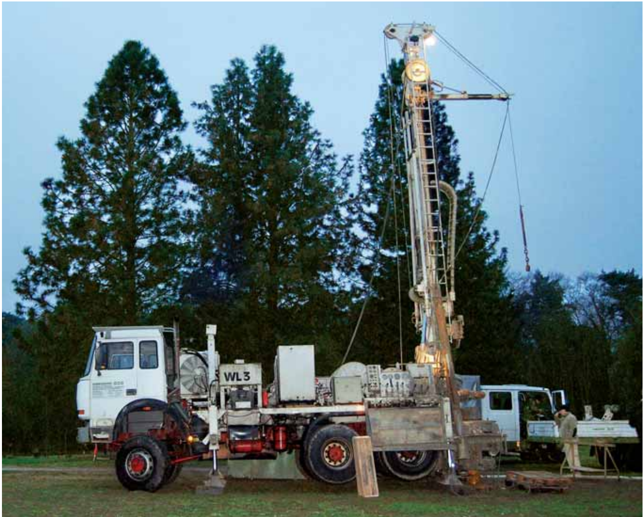
Abbildung 2 Abteufen der Erdwärmesondenbohrungen auf der Lichtwiese im Dezember 2008.
