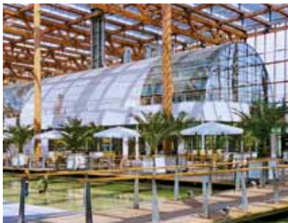
Abbildung 6 Fortbildungsakademie Mont-Cenis, Innenraum unter Glasdach mit Photovoltaik, gebaut bis 1999.
